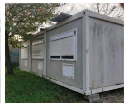
Algecos (sur désignation)
